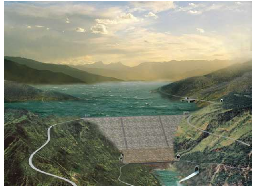
Chinesischer Asphaltbeton-Steinschüttdamm für das Frieda River Kupfer-Gold-Minenprojekt in PNG vorgesehener Damm, 191 Meter hoch, soll Erdbeben der Stärke 8,4 standhalten, (Foto: www.chincold.org.cn )
